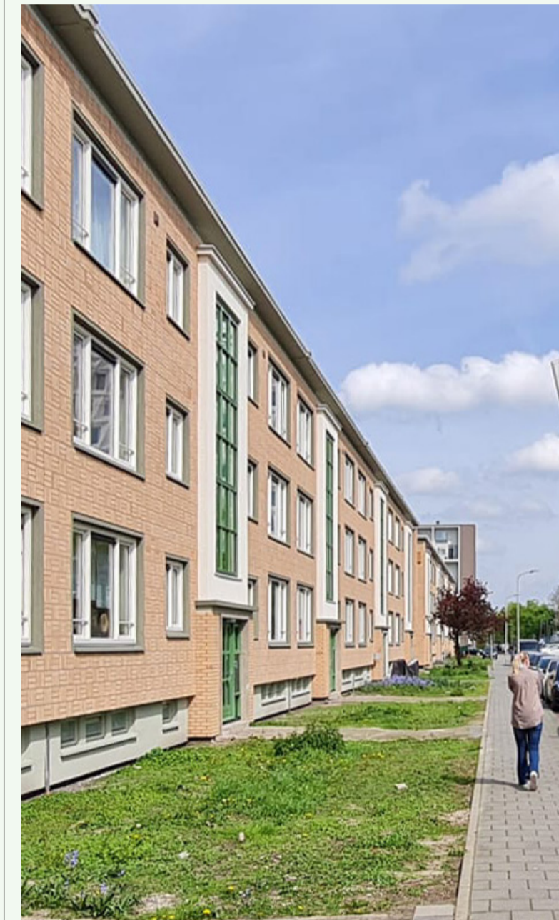
De vernieuwde woningen aan de Coevordenstraat
