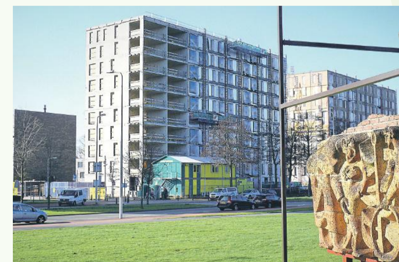
De twee wooncomplexen Castor & Pollux in aanbouw, met rechts op de voorgrond een stuk van het beeldhouwwerk dat alkomstig is van de gesloopte flats
